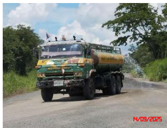
รูปที่ 6 การฉีดพรมน้ำเพื่อป้องกันและลดผลกระทบด้านฝุ่นละออง
