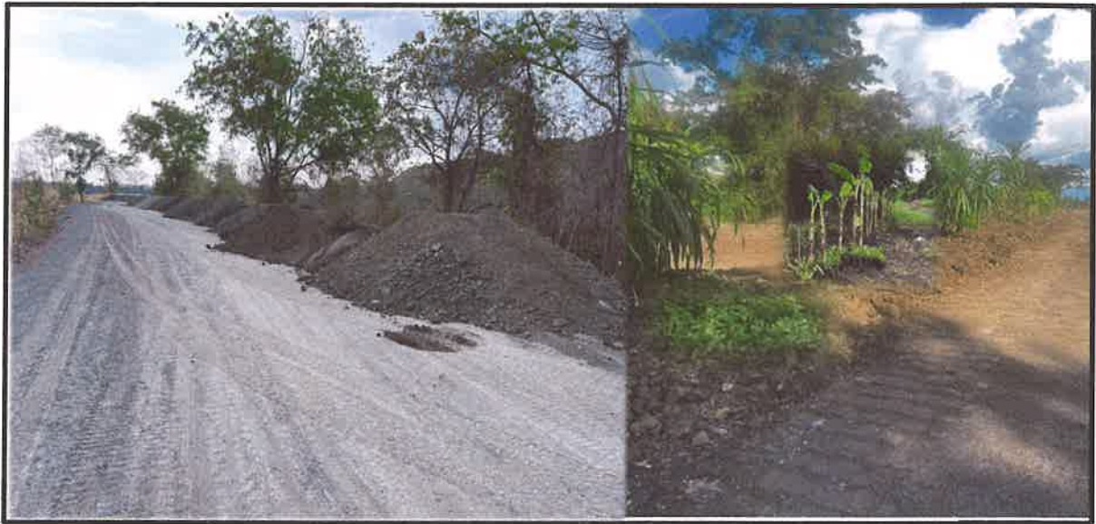
รูปที่ 9 รูปประกอบพื้นที่กองเก็บเปลือกดินและเศษหินที่เตรียมไว้บริเวณทางขึ้นปากโมโดยมีการปลูกต้นไม้เพื่อป้องกันการพังทลายของหน้าดิน
