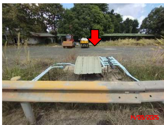
รูปที่ 9 ระบบสเปรย์น้ำล้างล้อรถบรรทุก
