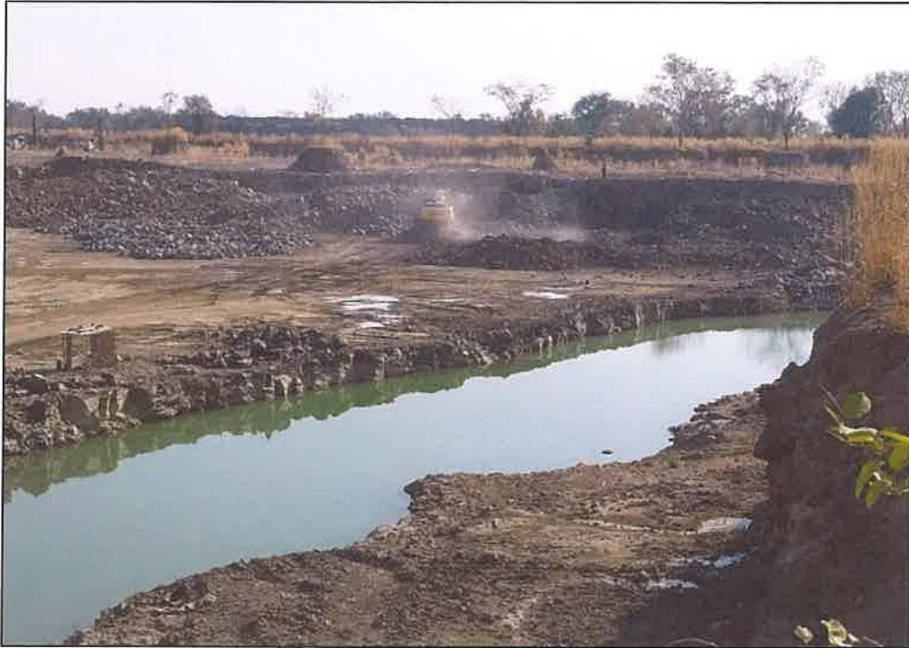
รูปที่ 4 ปอดกักเก็บน้ำและปอดักตะกอนบริเวณหน้าเหมือง
